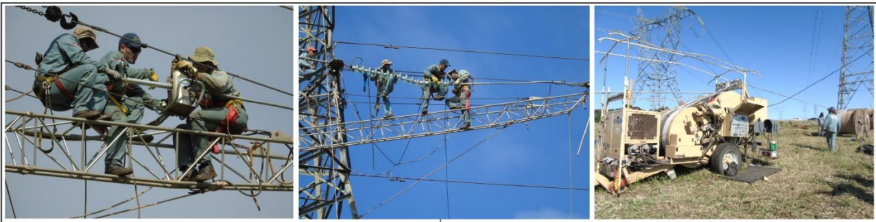
Figura 2: Trabajos de tendido de línea (L3 tramo SEMD-SEPIH)
